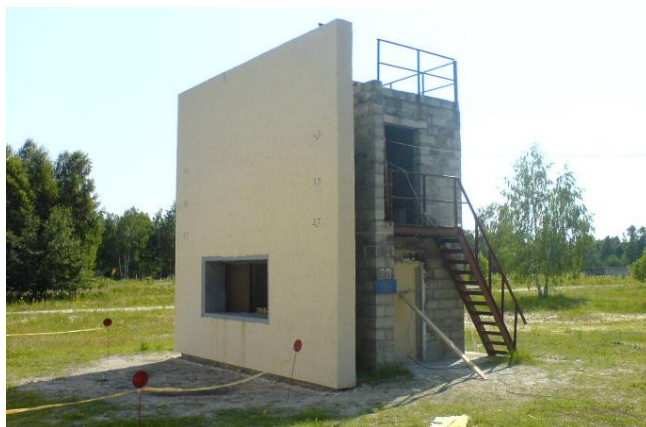
Рисунок 2 – Загальний вигляд фрагмента будинку для проведення експериментальних досліджень
