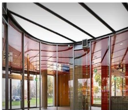
Ryc. 8. – Hole służące do ewakuacji ludzi z klatki schodowej na zewnątrz wymagają wydzielenia ścianami o odporności ogniowej, na ogół klasy REI/EI 60 lub REI/EI 120
