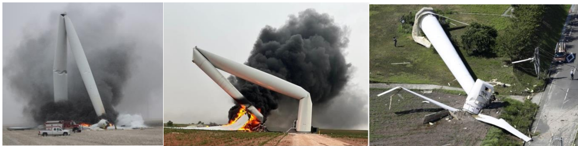
Рис. 2. Фото руйнувань вітрових електроустановок, що супроводжувалися пожежами й пошкодженням прилеглої інфраструктури
