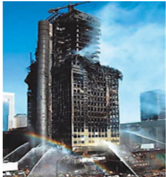
Рис. 3. Наслідки пожежі в 32-поверховому хмарочосі (Мадрид. Іспанія, 2005 рік)
