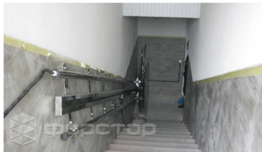
Рис. 5. Встановлення похилого підйомника на шляху евакуації в укритті
