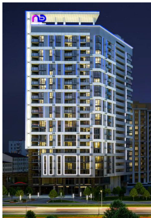
Рис. 1. Загальний вигляд житлового будинку у м. Львові
