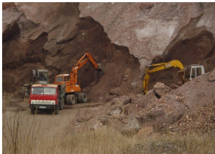
Рисунок 7 – Розбирання згаслого терикону для потреб будівництва
