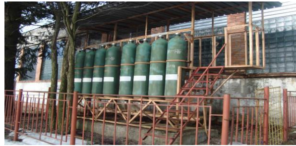
Рис. 2. Схематичне зображення балонної водневої рампи з 40-літровими та 160-літровими водневими балонами (а) та загальний вигляд типової водневої рампи (б)
