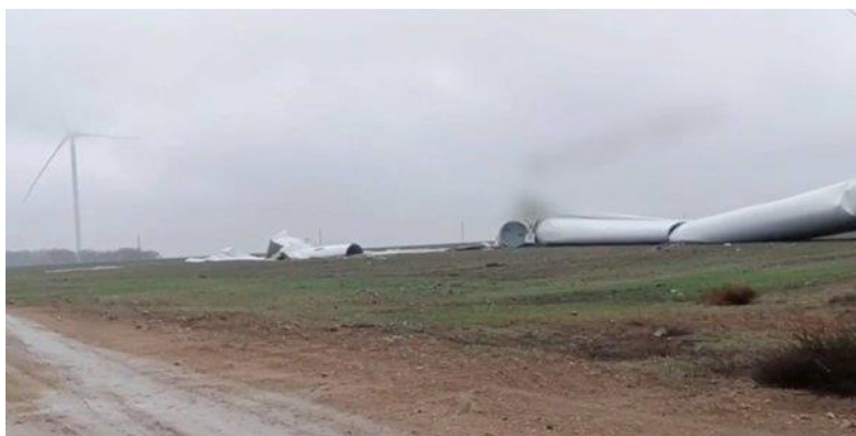
Рис. 5. Падіння вітрової електроустановки внаслідок удару військового безпілотної літального апарату
