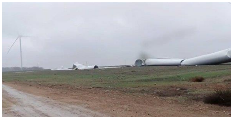
Рис. 5. Падіння вітрової електроустановки внаслідок удару військового безпілотного літаючого апарату
