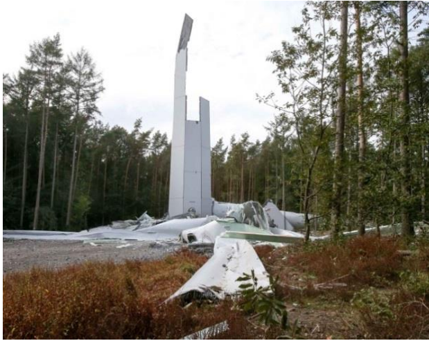
Рис. 1. Фото випадку механічного пошкодження вітрової електроустановки й ситуаційна діаграма дистанції розсіювання їх уламків за 2008–2018 роки
