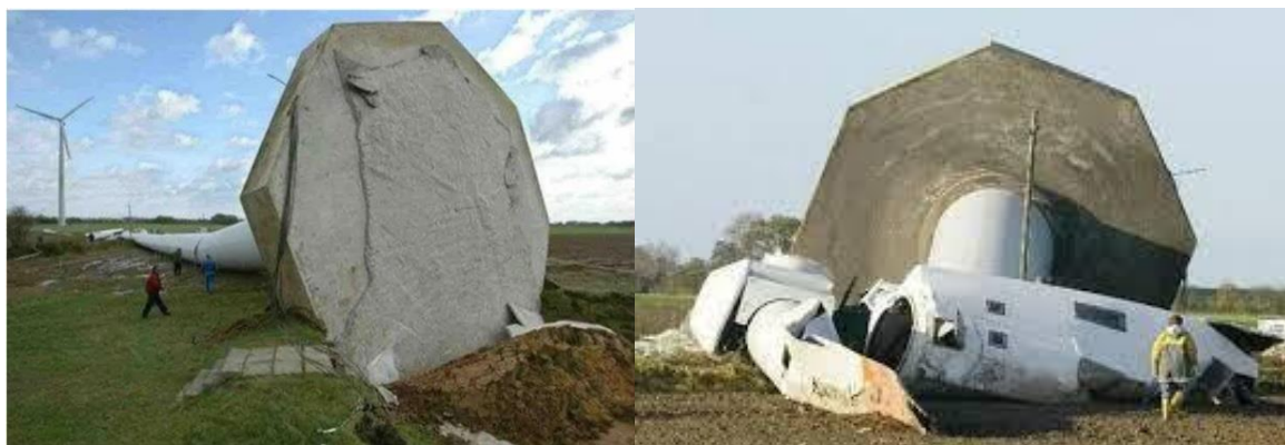
Рис. 4. Фото падіння вітрової електроустановки через руйнування основи у 2019 році, США
