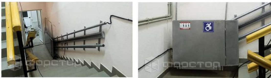
Рис. 3. Встановлення похилого підйомника на шляху евакуації дошкільному навчальному закладі
