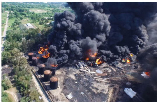
Рис. 12. Зображення наслідків аварії на підприємстві зі зберігання СПГ після вибухової хвилі та займання
