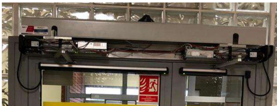
Ryc. 3. – Napęd drzwi przemykowych
