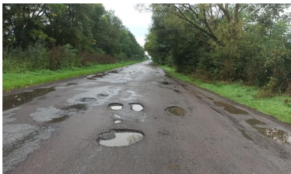
Рисунок 2 – Фото ділянки автомобільної дороги Т-1418 із незадовільним дорожнім покриттям
