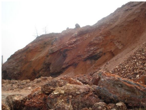
Рисунок 7 – Процеси ерозії та зсуви на териконі «Шахти №4 Нововолинська»
